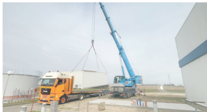
Rys. 2. Dostawa kontenera (fot. Cempuro)
